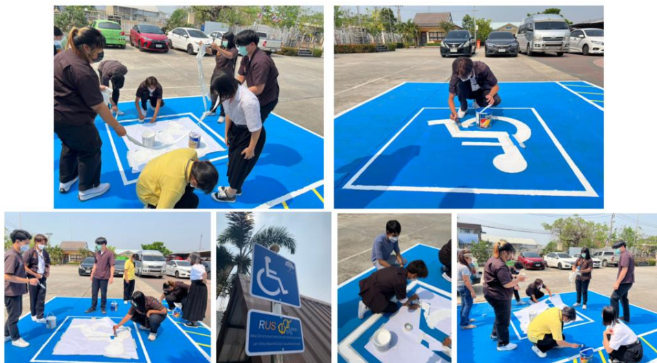
ทาสีและติดตั้งป้ายจอดรถคนพิการ
